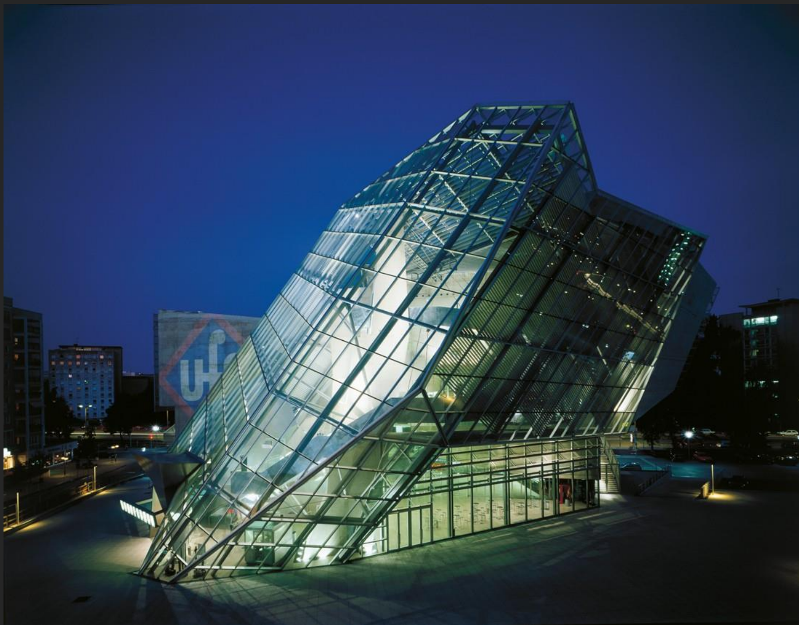
Ufa Cinema Center - Coop Himmelb(l)au_Дрезден
