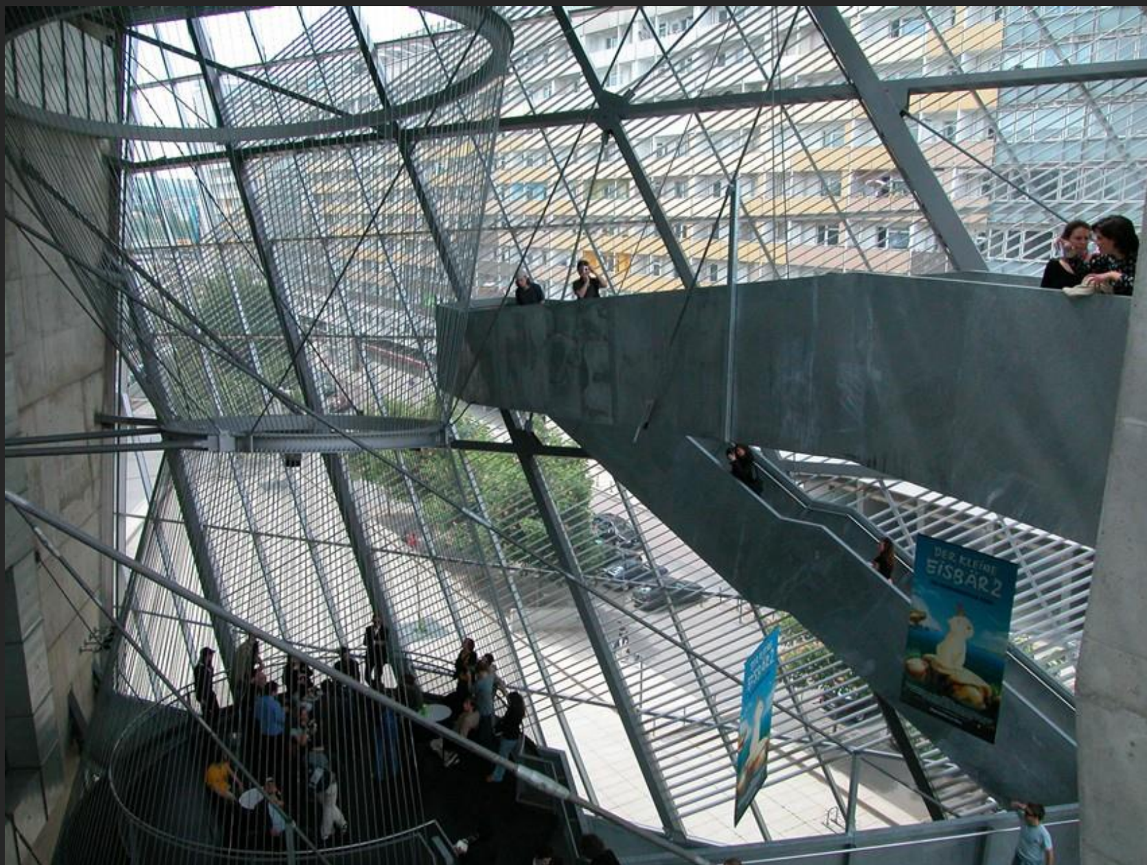
Ufa Cinema Center - Coop Himmelb(l)au_Дрезден
